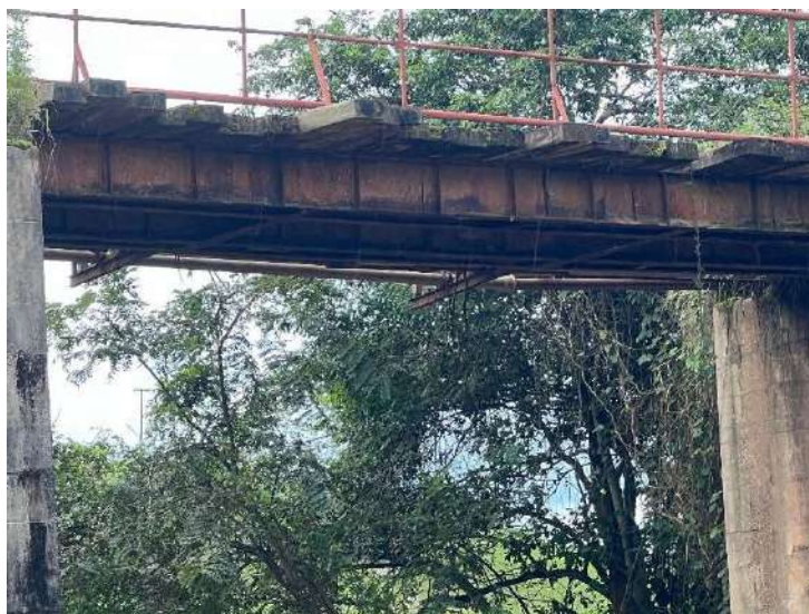
Sistema de longarinas existentes
