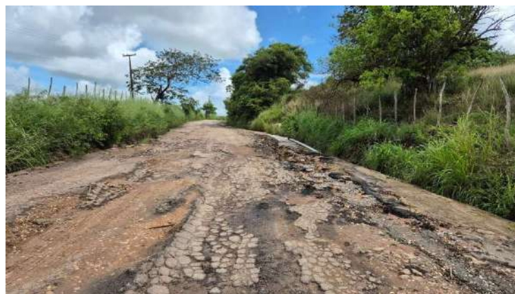
Via municipal em pavimentação asfáltica existente
