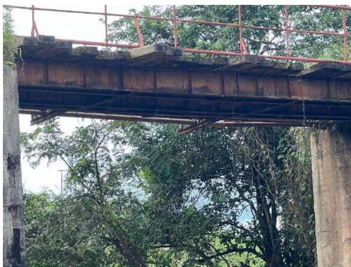
Sistema de longarinas existentes
