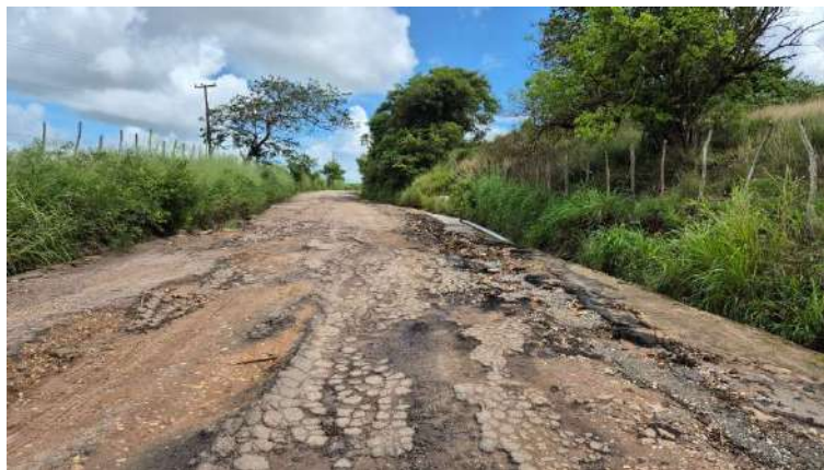
Via municipal em pavimentação asfáltica existente
