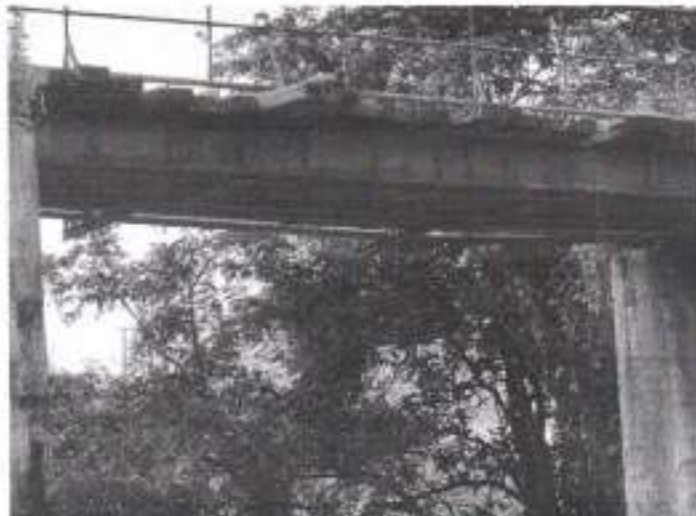
Sistema de longarinas existentes
