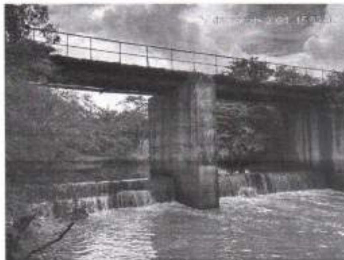
Base estrutural existente
